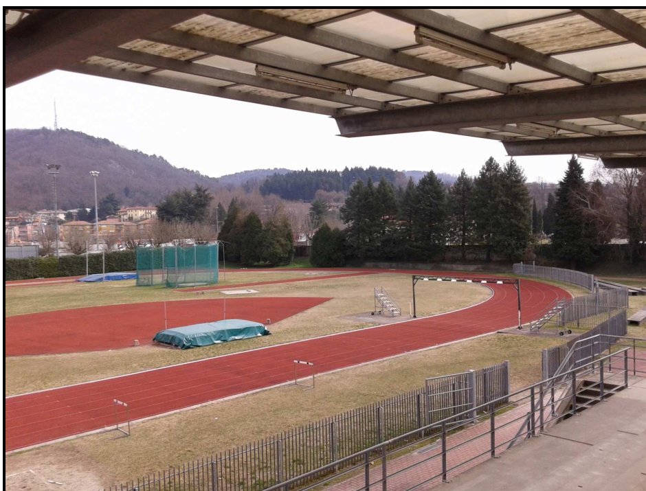
Pista di atletica – vista dalla tribuna all'anello lato sud est (cono ottico n. 2)
