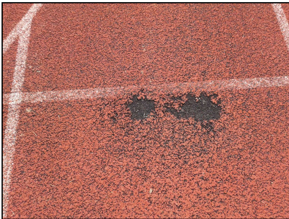
Manto sintetico usurato in prossimità della partenza (foto n.6)
