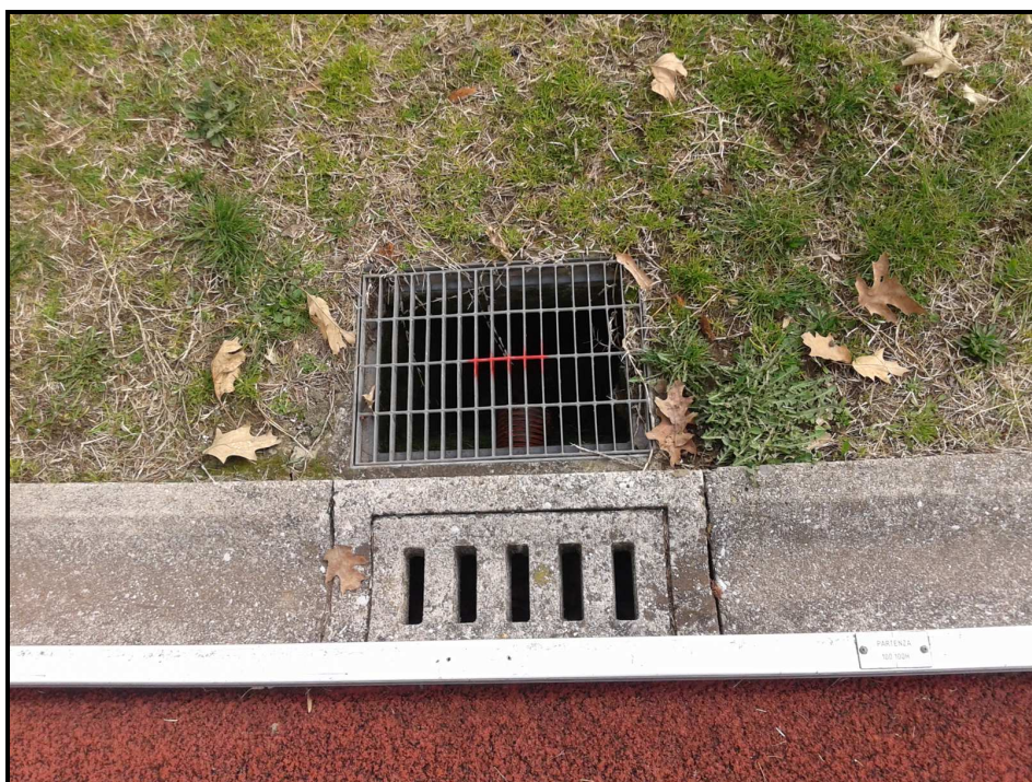
Dettaglio griglia di scolo acque meteoriche (foto n. 8)
